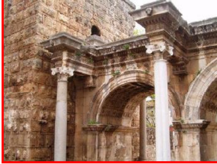
Resim 1.1: Yapının yüzey kaplama malzemeleri ve kullanım şekli
